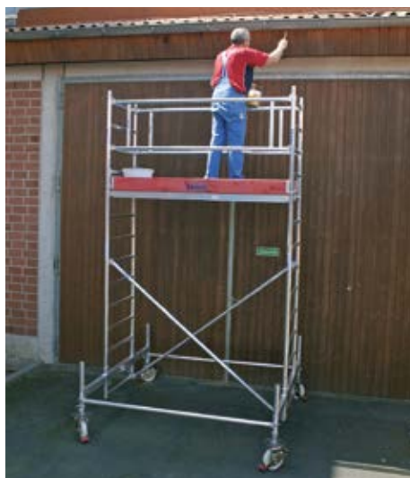
73100 Długość pola rusztowania: 2,00 m – Szerokość pola rusztowania: 0,75 m
